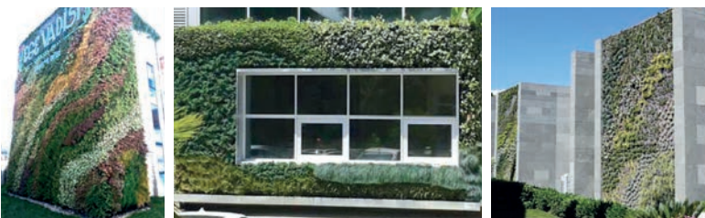
Şekil 1: “Ege Vadisi Satış Ofisi” (solda), “İTÜ Teknokent Arı 6” (ortada) ve “Swissotel” (sağda) BCS uygulamaları
