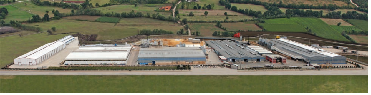
Hekim Yapı'nın Sakarya Hendek'teki üretim tesisi
